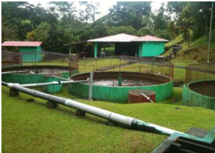
Foto 5. Pilas circulares concreto para engorde de tilapia. Proyecto Tilapal en la Marina de San Carlos.
