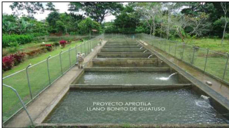
Foto 7. Estanques de concreto, producción intensiva de tilapia, proyecto de la Asociación de Productores de Tilapia (Aprotila), ubicado en Llano Bonito de Guatuso.
