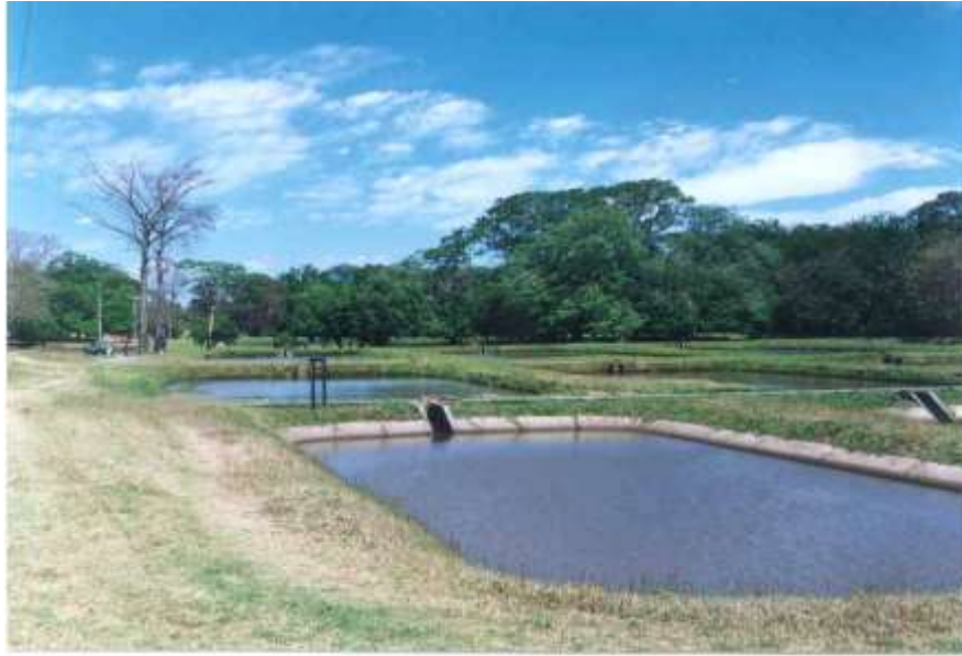
Foto 4. Estanques concreto y tierra, estación acuícola Enrique Jiménez Núñez, cañas, Guanacaste.
