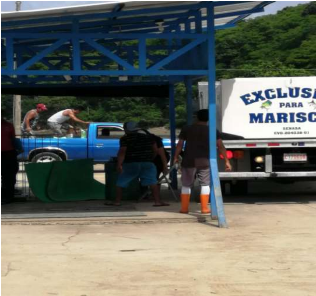
Figura. 20. Cubierta de pantalla existente.
