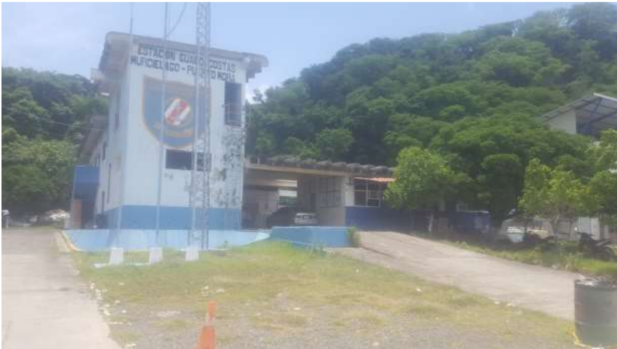
Figura 23. Vista de lugar donde se construirá la nueva rampa Fuente: Manrique Quirós Luque
