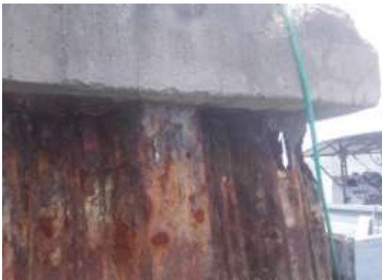
Figuras 16-17-18-19. Deterioro de Tablaestaca en la junta con la viga de concreto Fuente: Manrique Quirós Luque
