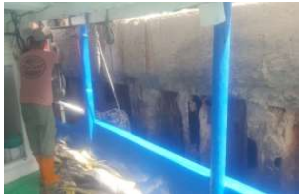
Figuras 16-17-18-19. Deterioro de Tablaestaca en la junta con la viga de concreto Fuente: Manrique Quirós Luque
