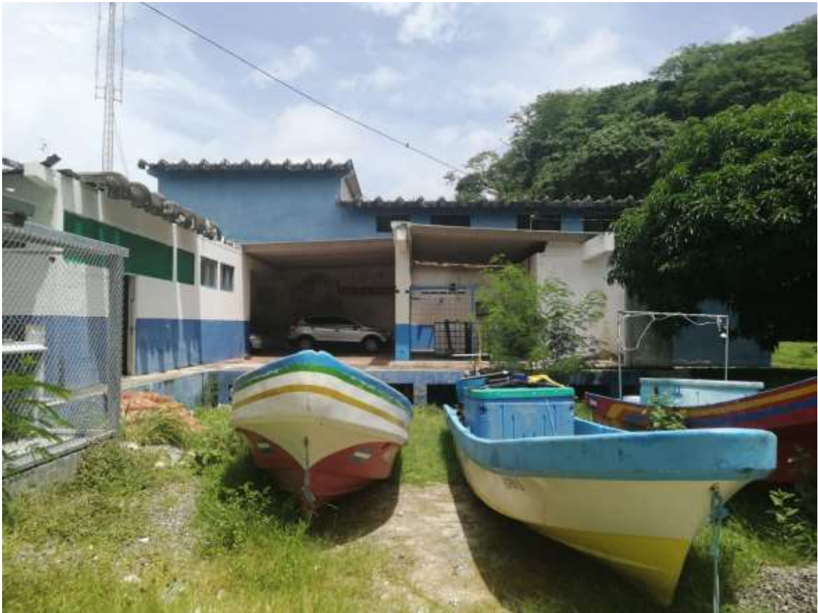
Figura 22. Edificios a demoler para construir Planta de Proceso y Andén Fuente: Manrique Quirós Luque
