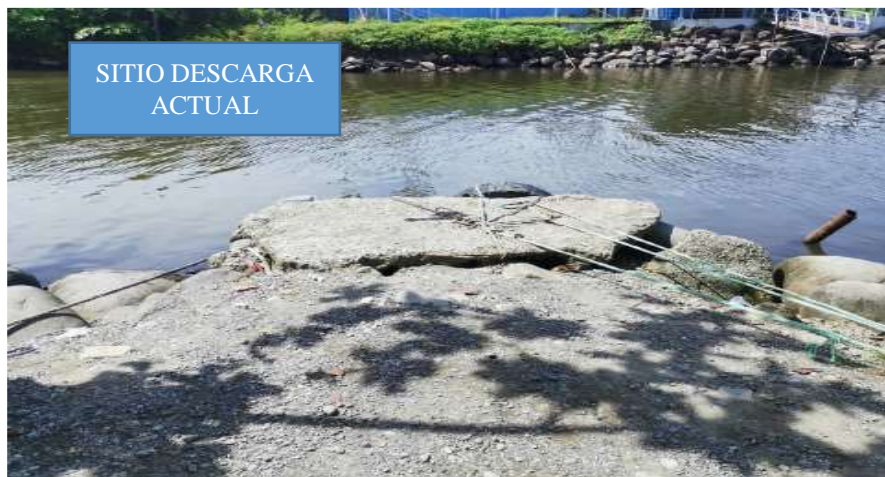
Figura 7. Vista de losa de concreto donde se realizan las descargas actualmente Fuente: Manrique Quirós Luque
