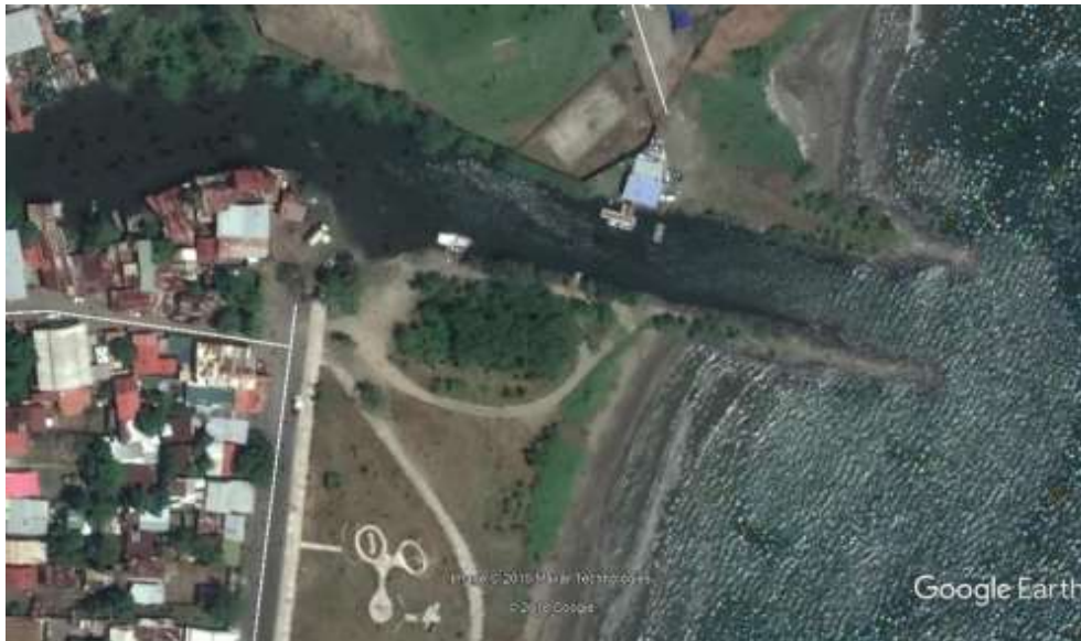
Figura 28. Vista aérea de zona del proyecto
