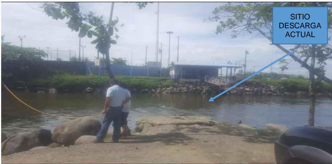
Figura 9. Pantalla de descarga sobre Río Cieneguita Fuente: Manrique Quirós Luque
